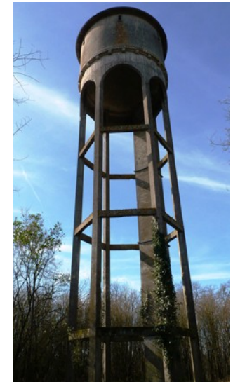
Château d'eau – D424
